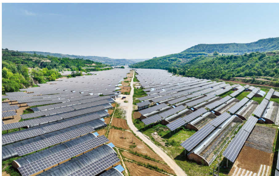
水发集团新能源电站
