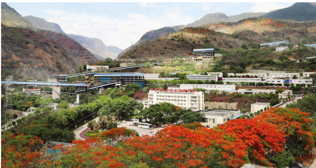
大红山矿业尾矿库建设
